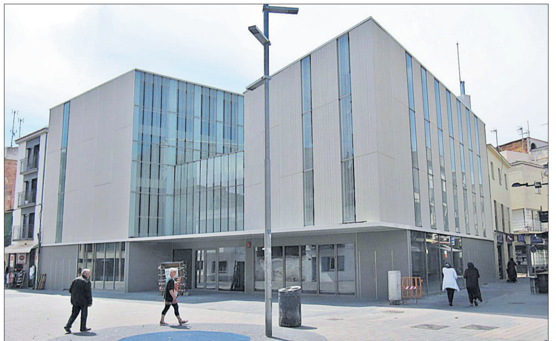
L'edifici de la SUF, pràcticament acabat però pendent de poder-se estrenar. GERARD BLANCHÉ
