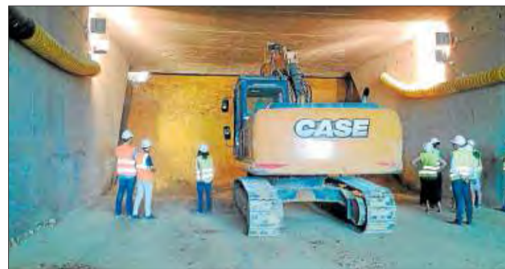
El calaix de formigó per sota el cinturó de ronda de l'N-II. DIARI DE GIRONA
