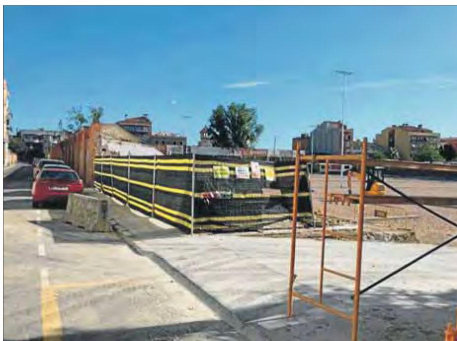
El pàrquing del carrer del Far, durant els treballs de preparació ■ JOAN PUNTÍ
