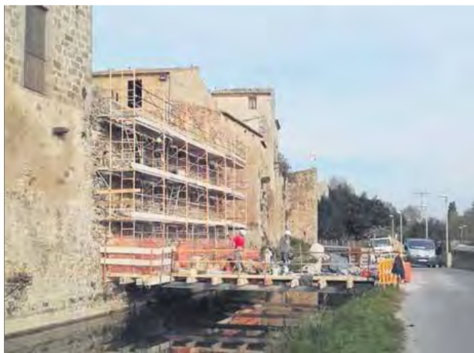
Una imatge de les obres al tram del mirador d'en Malino ■ J. CANET
