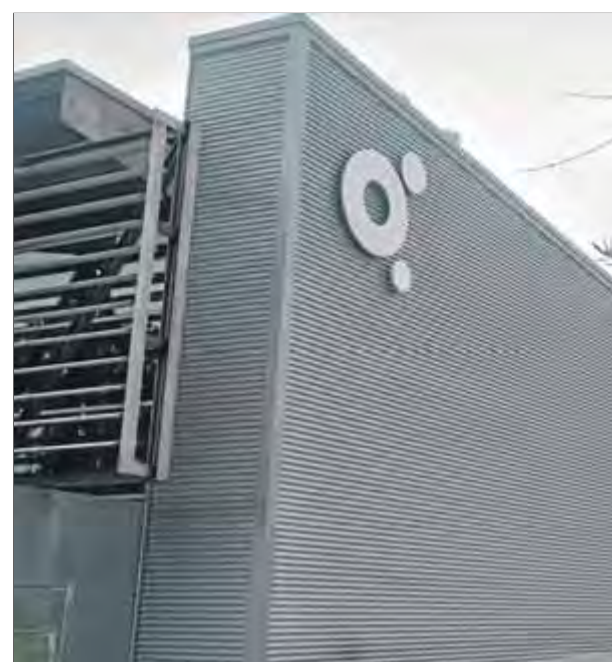
La nova imatge de la façana de l'edifici, amb miniona de xapa prelacada ■ AJ. ROSES
