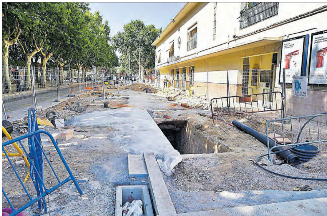
El refugi antiaeri de Figueres davant de l'Estació, durant la represa dels treballs. CONXI MOLONS
