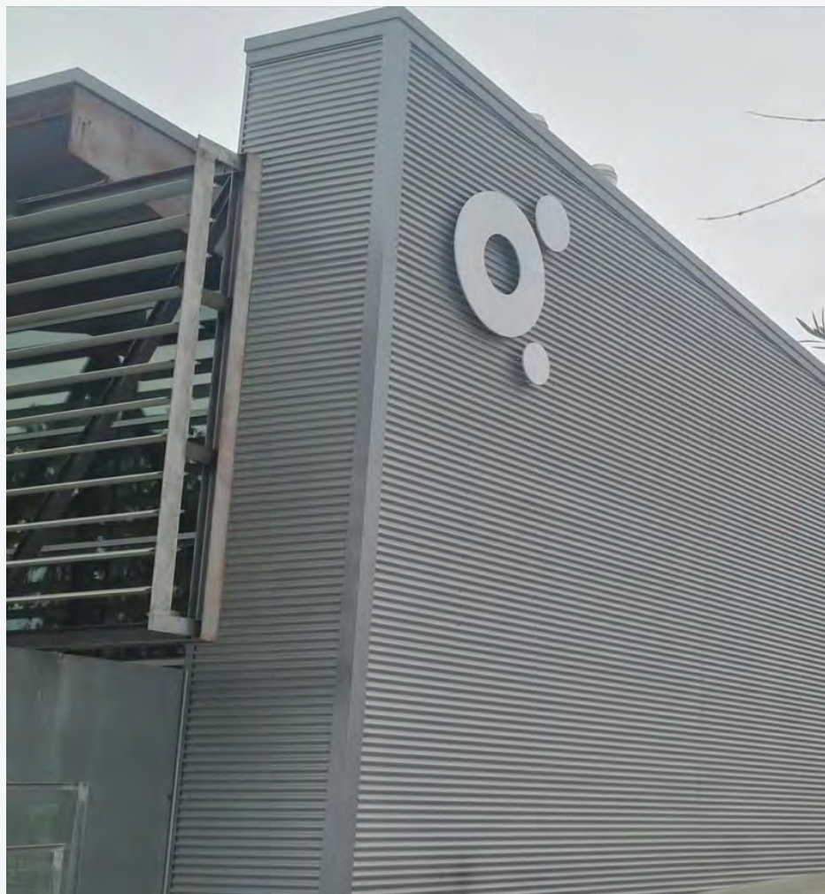
La nova imatge de la façana de l'edifici, amb miniona de xapa prelacada A.J. ROSES.
