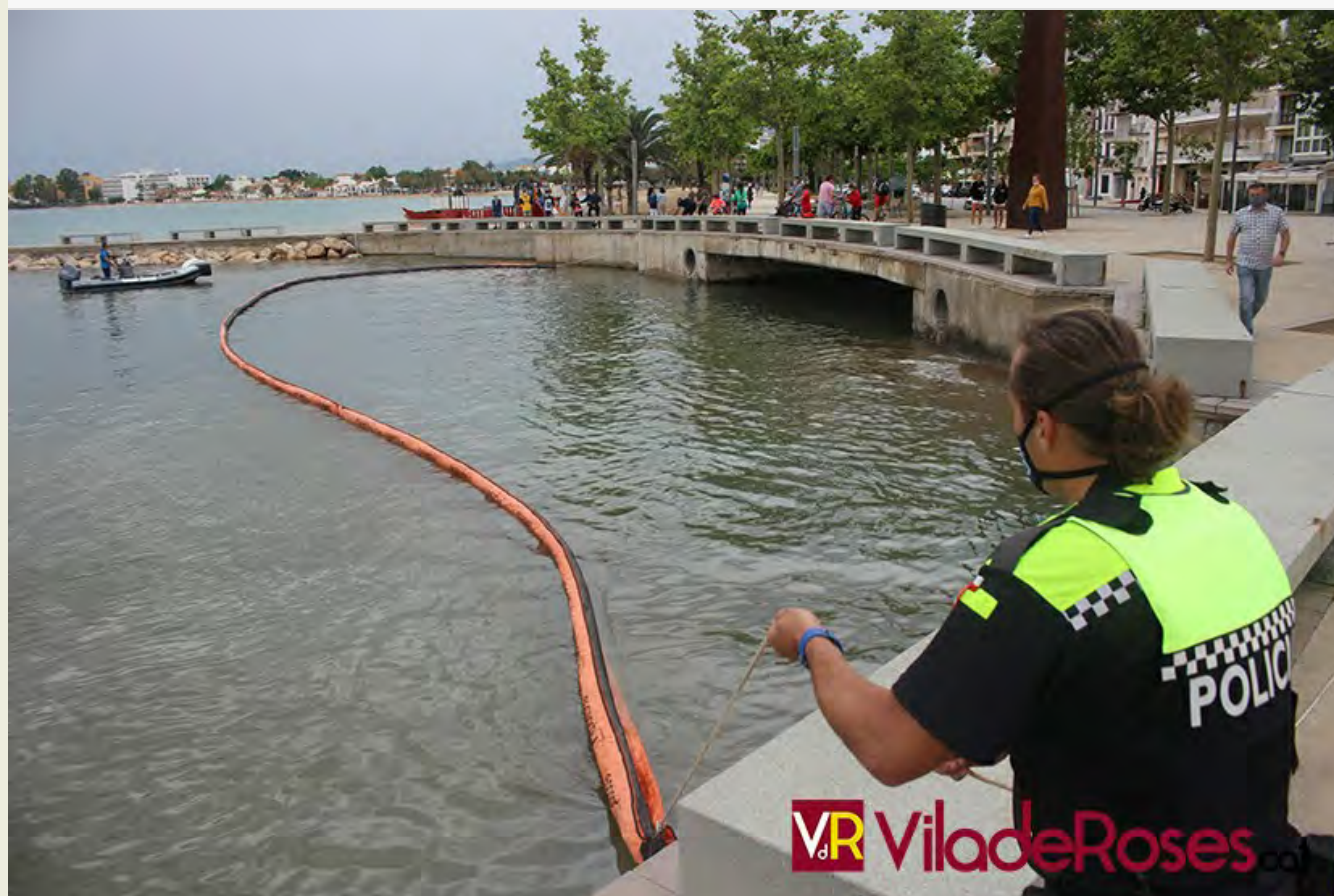
Moment en que s'instal·lava la barrera de contenció per a que el gasoli no s'escampés per la badia de Roses
