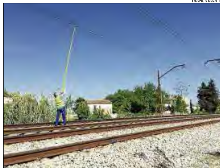
Un operari treballant per retirar el cablejat malmès de la via.
