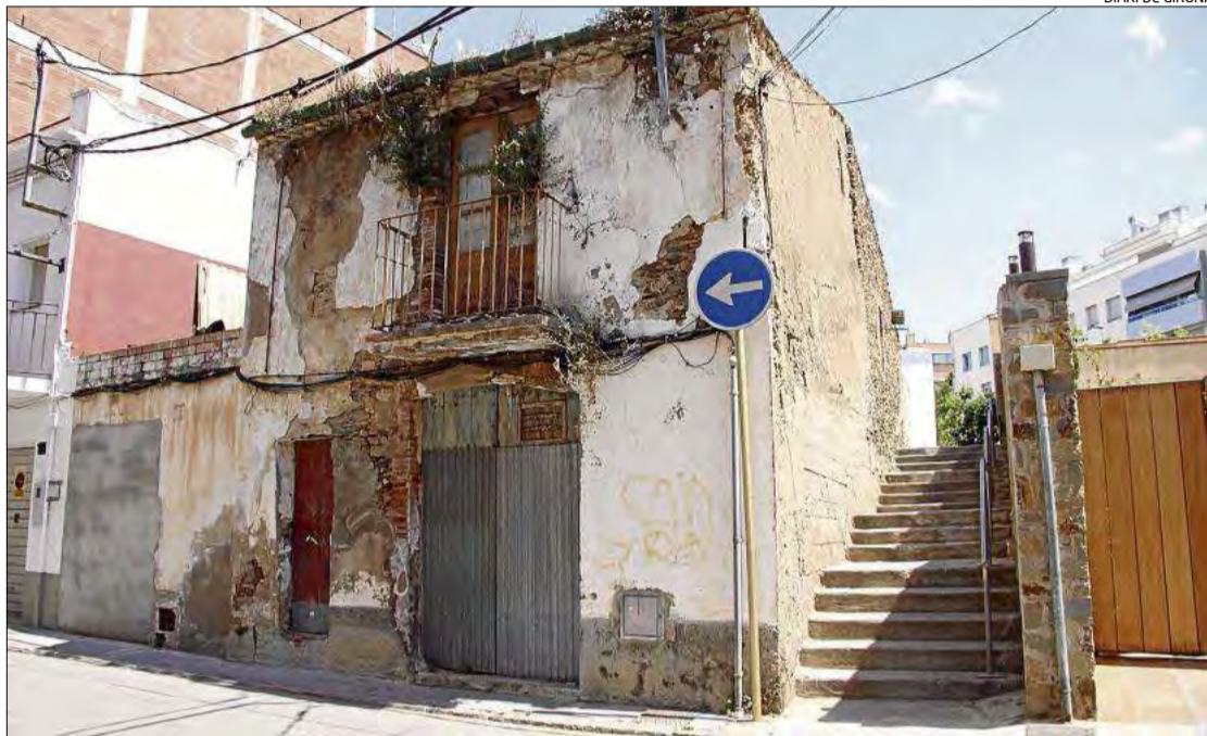
La finca del carrer Trinitat, que ha adquirit l'Ajuntament de Roses i que s'enderrocarà.
