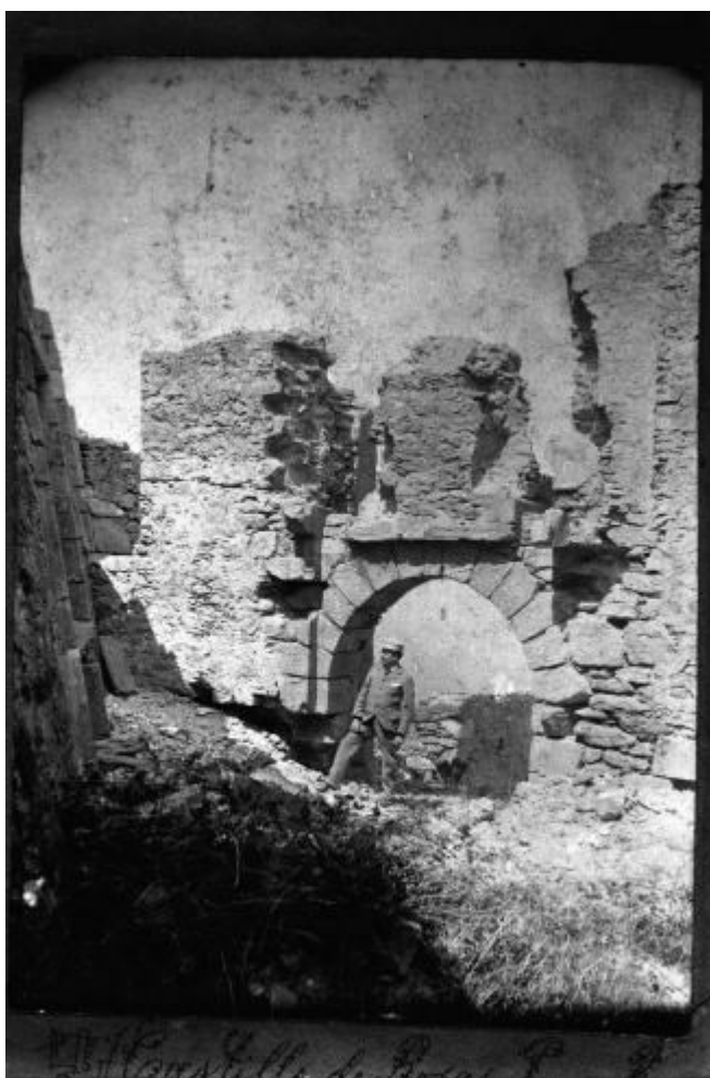
Retrospectiva del Castell de la Trinitat ARXIU DE ROSES
