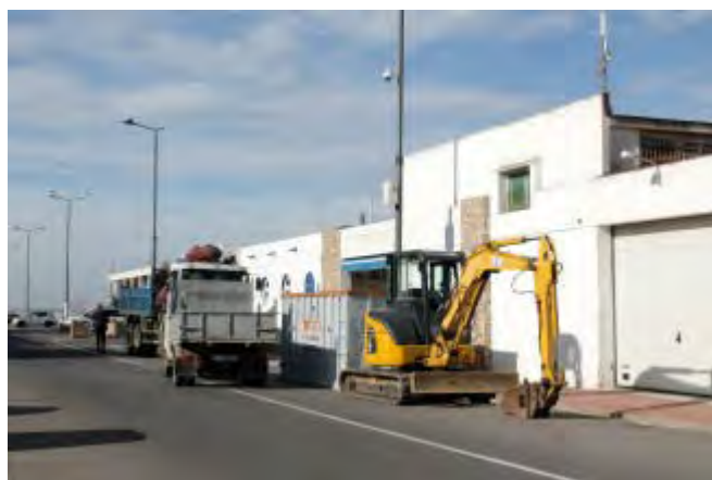
Inici de les obres al port pesquer de Roses . EMPORDA.INFO
