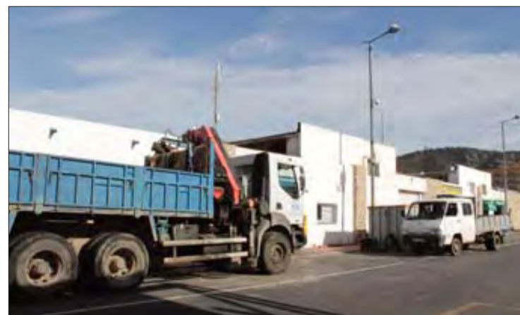
Les obres a l'espai que acollirà l'Aula Gastronòmica. AJUNTAMENT DE ROSES
