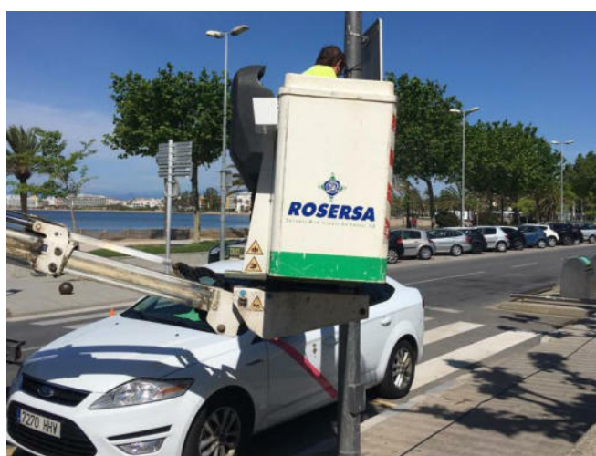
La instal·lació de la màquina. EMPORDA.INFO
