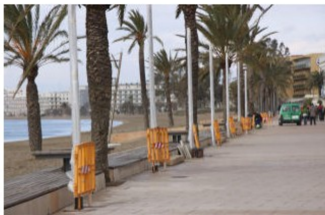
Un dels trams en obres. EMPORDA.INFO
