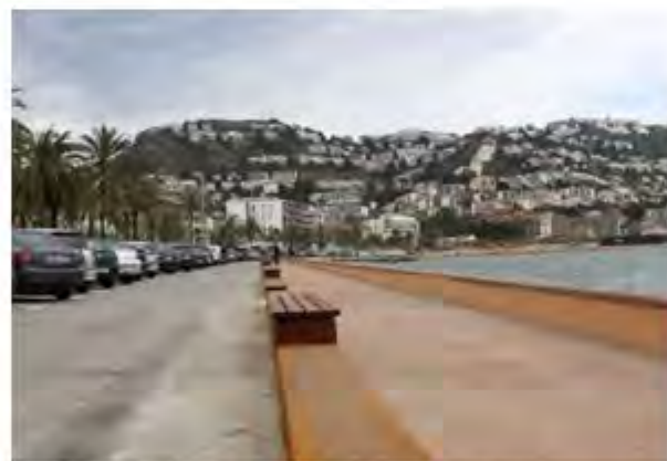
Passeig peatonal aparcament Avda de Rhode
