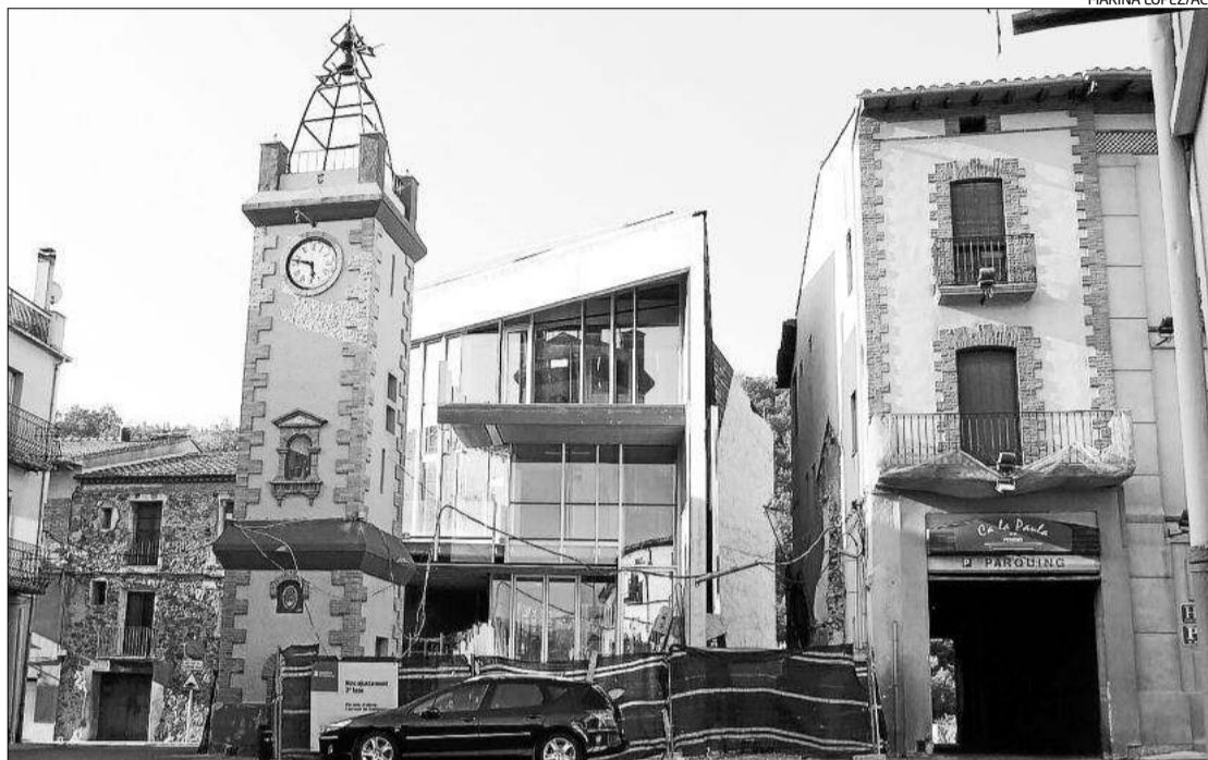
Imatge de l'edifici en obres, i encara sense sentència ferma, el mes de setembre del 2010.
