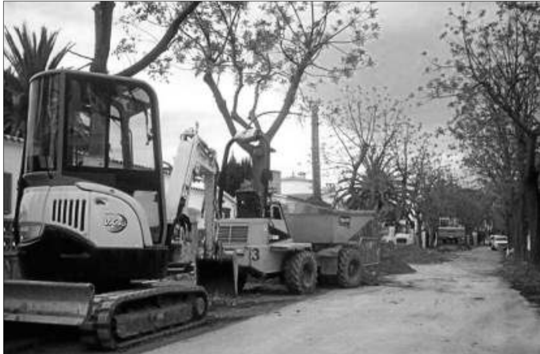
Les màquines treballant en les obres del clavegueram d'Empuriabrava.
