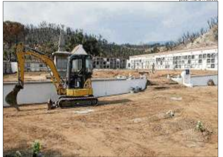
Les obres per refer de les flames el cementiri de la Jonquera.
