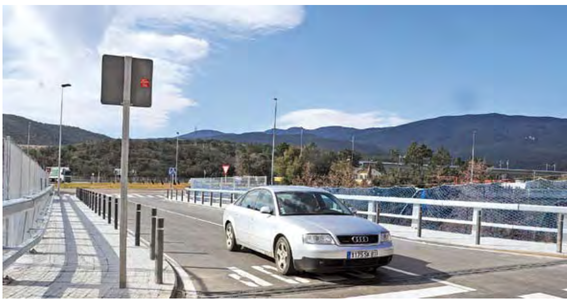
OBRES ENLLISTIDES. La nova N-II a la Jonquera a l'alçada del pont de la Duana
