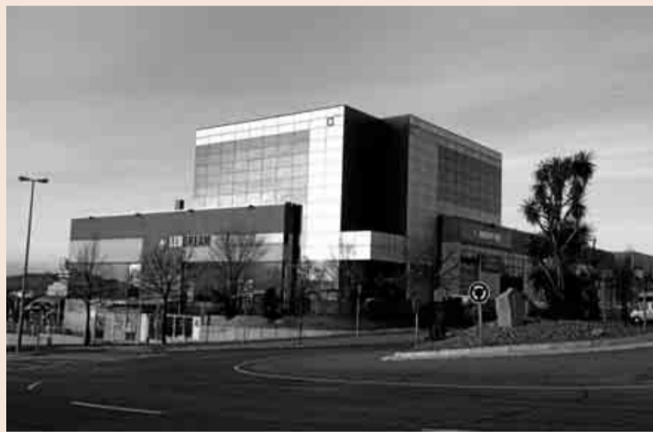
ADI se ha trasladado a un nuevo edificio corporativo en Terrassa (Vallès Occidental).
