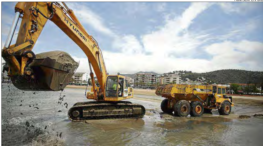
Les màquines treballant en l'extracció de la sorra per a traslladar-la a les platges.
