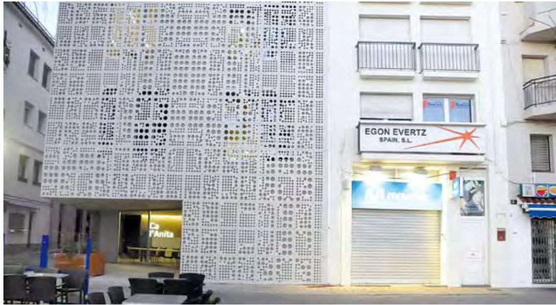
CA L'ANITA. El projecte va ser finalista als Premis d'Arquitectura de Girona i les obres van acabar el 2011
