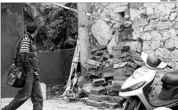
Foto de la caiguda d'un mur per la intensa precipitació d'ahir, a Girona.
