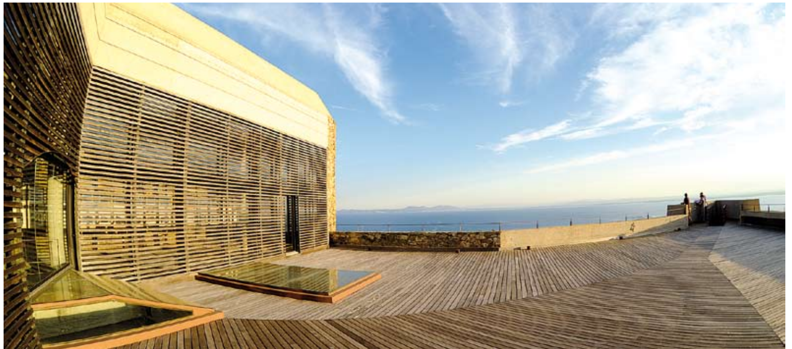
REHABILITACIÓ. Les obres faraòniques de consolidació de l'estructura i adequació del castell es van acabar el 2010
