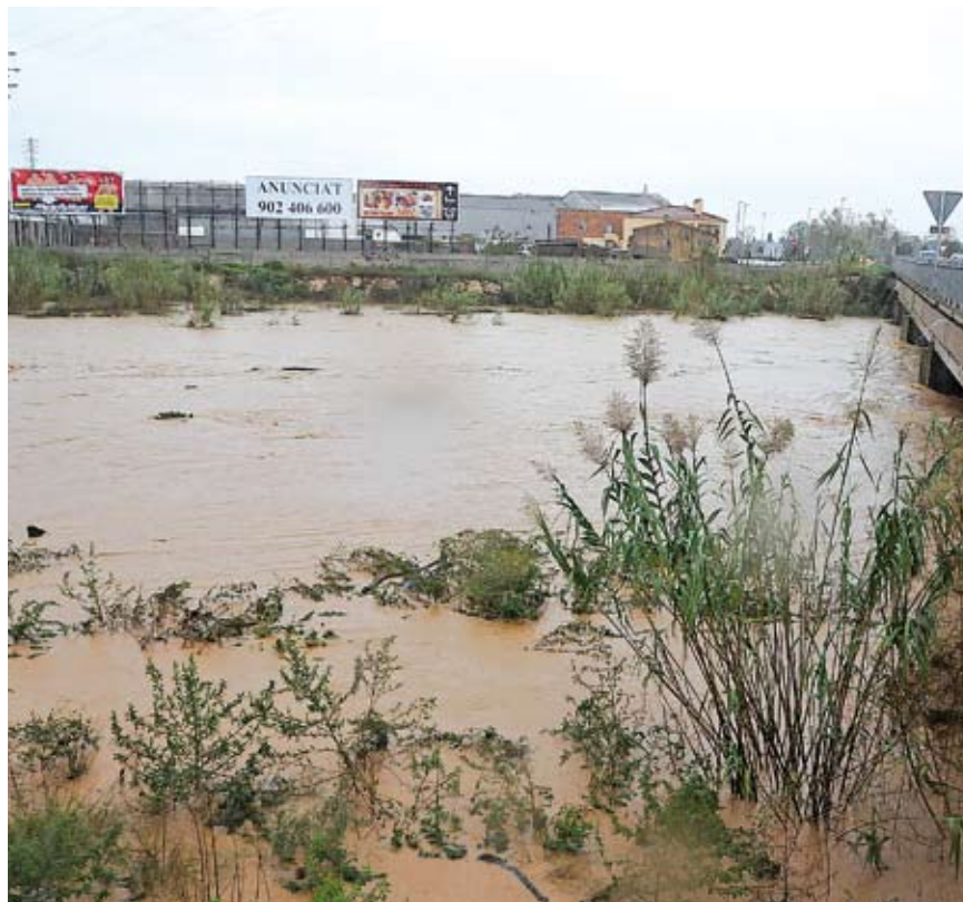
PONT DEL PRÍNCIP. La xarxa viària es va veure afectada al voltant d'aquesta zona
