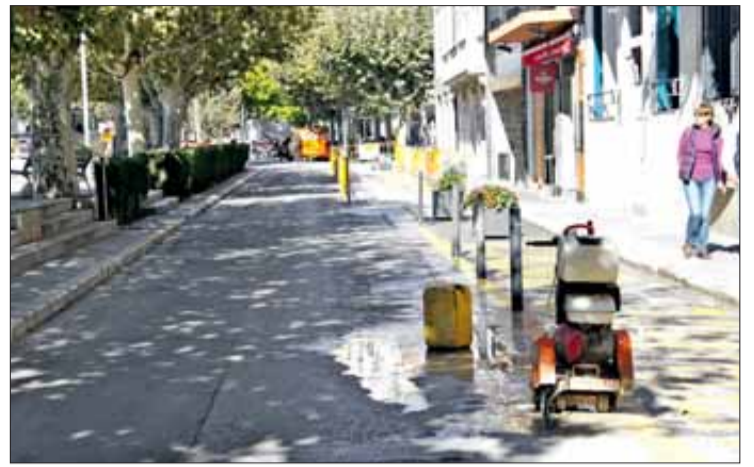
També es millorarà l'accessibilitat de l'espai. EMPORDÀ
