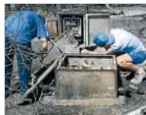
Uns operaris treballant en un quadre elèctric ■ J.S.
