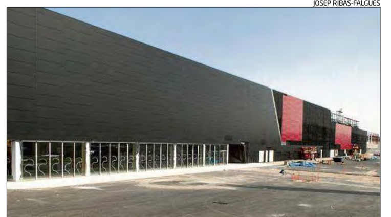
L'establiment «outlet» amb les obres molt avançades.
