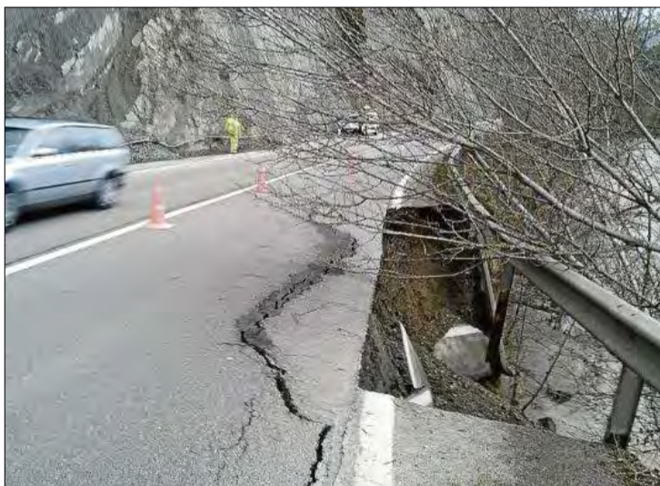
L'esvoranc de Ripoll va fer-se gran per la forta pluja. EL RIPOLLÈS
