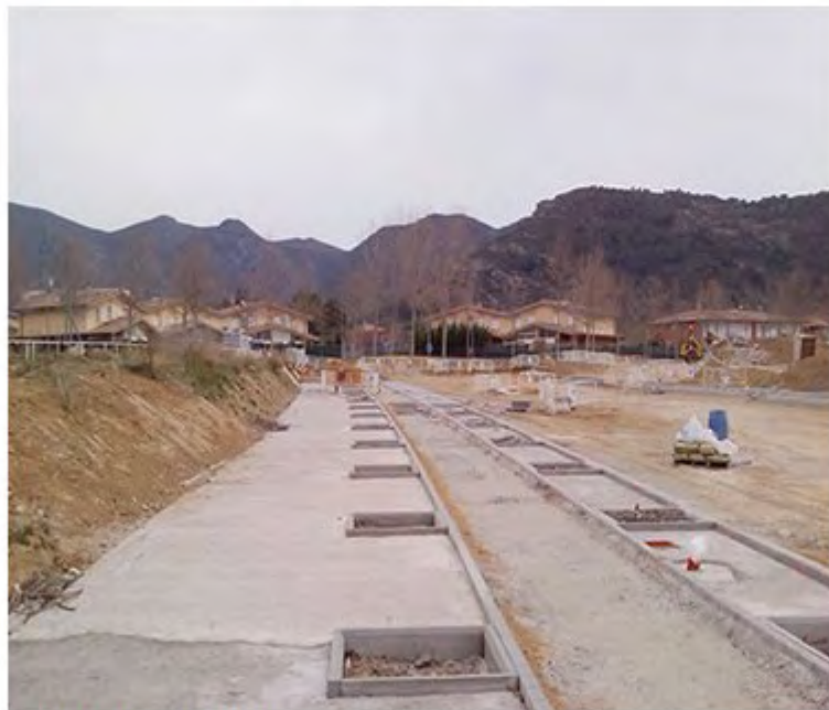
Estat actual de les obres del Vial Nord
