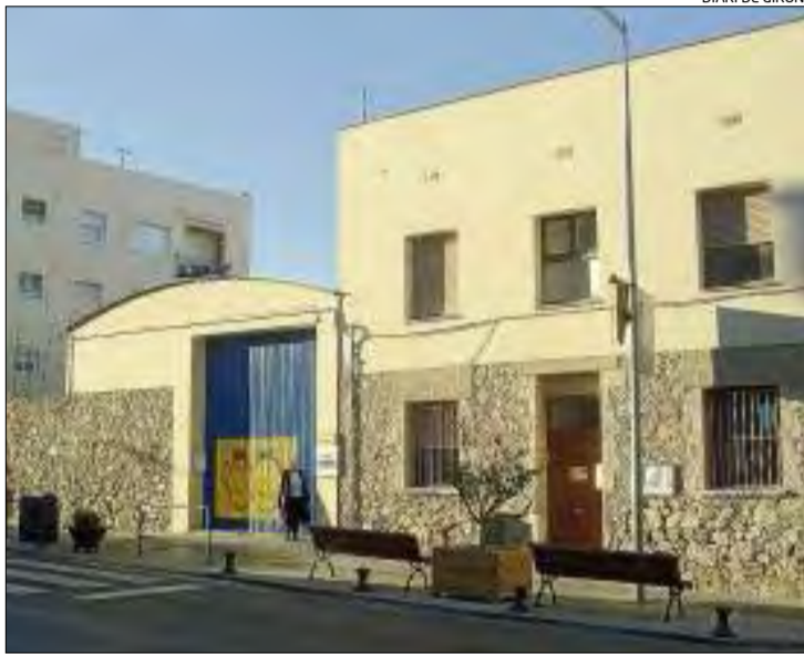
L'edifici conegut com Ca les Monges, al centre històric.
