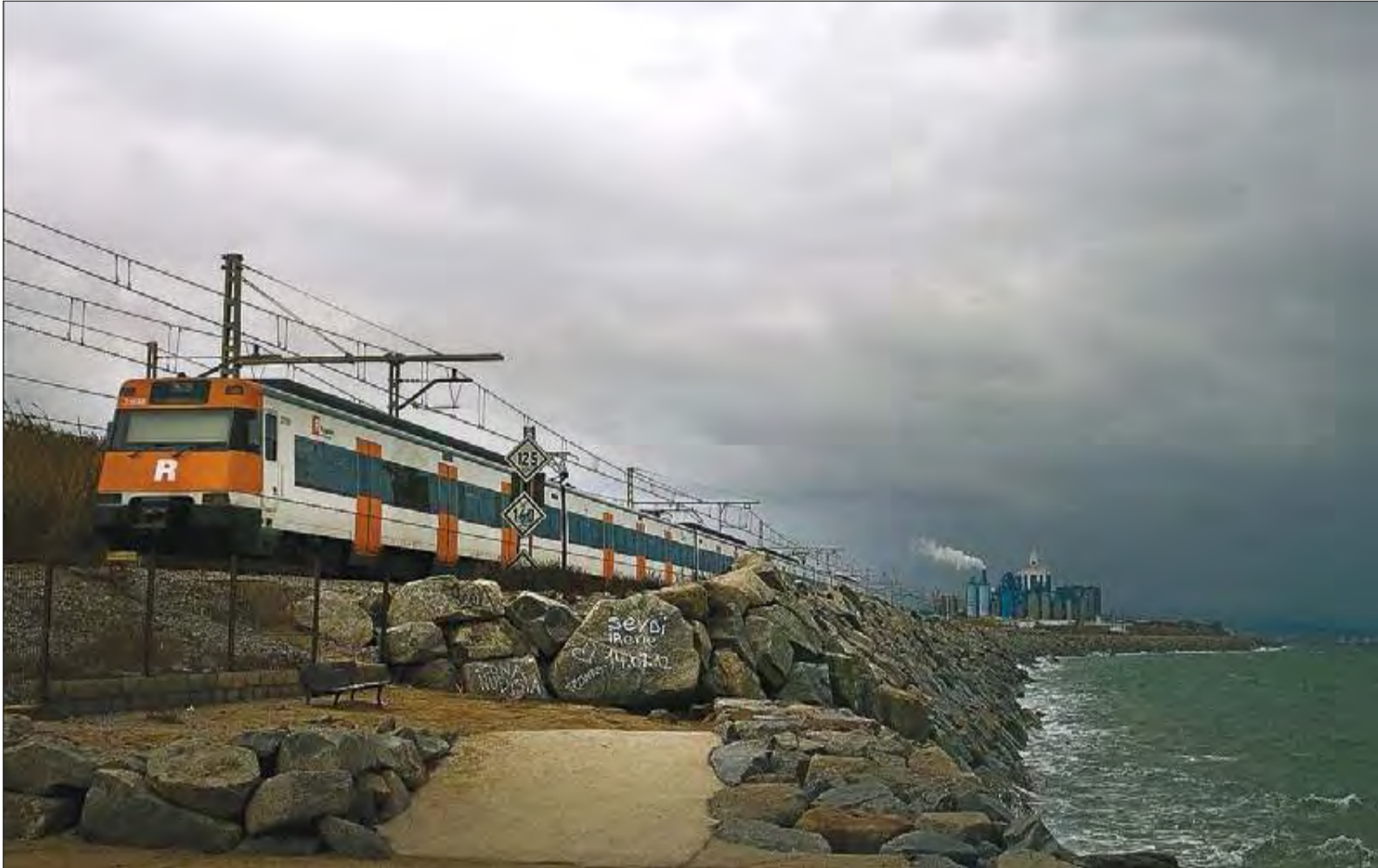
►► El mar impacta directament en l'escullera que protegeix la via fèrria al seu pas per Cabrera de Mar, ahir.
