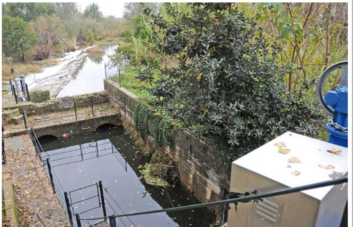
VILANOVA DE LA MUGA. En alguns punts s'han instal·lat comportes per regular el cabal i intentar reduir la salinització
