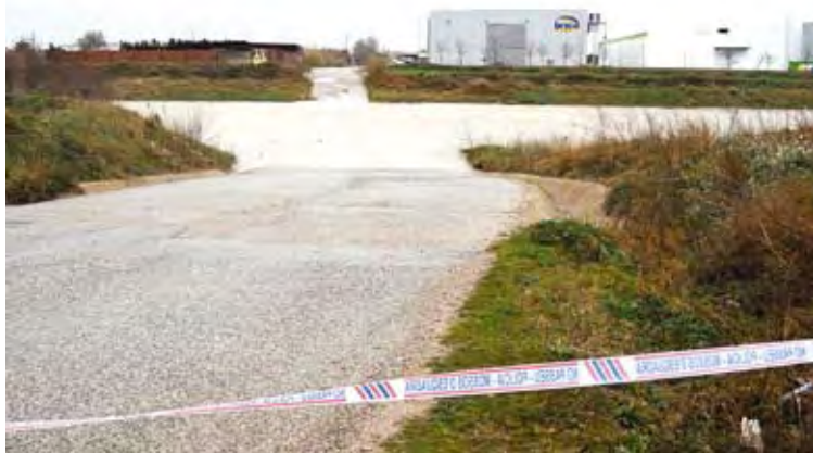
DIMECRES. Les pluges van obligar a tallar la carretera entre Vilatenim i el Far
