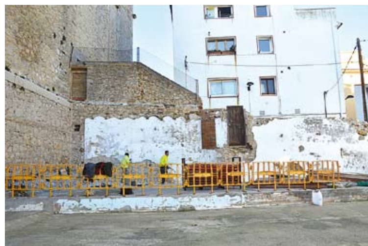
L'ESPAL. Així va quedar el solar després de l'enderrocament de la Pluma
