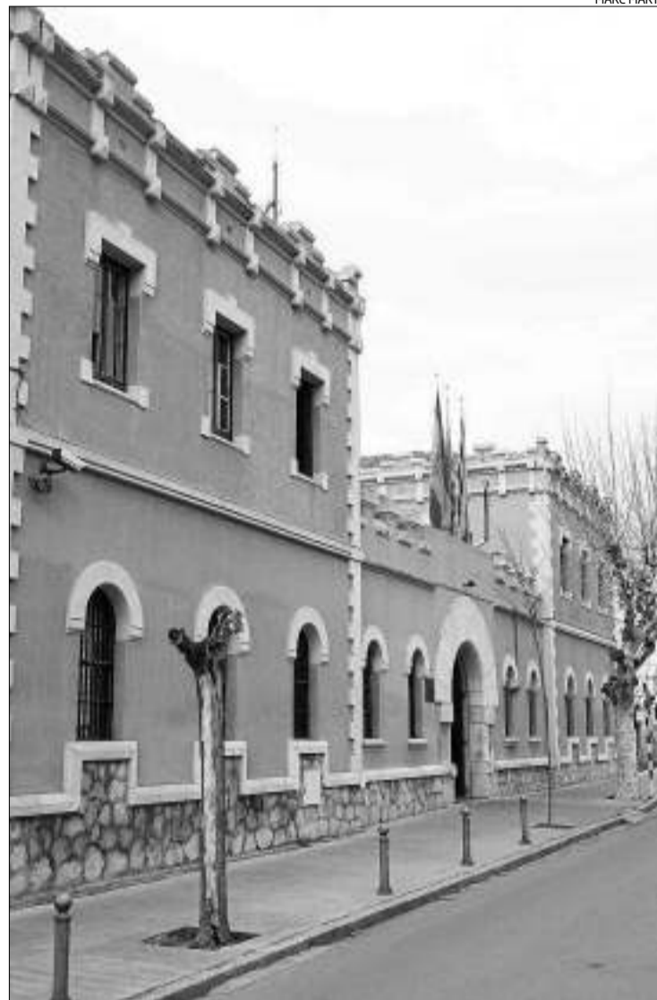
La façana de l'actual presó de Figueres.
