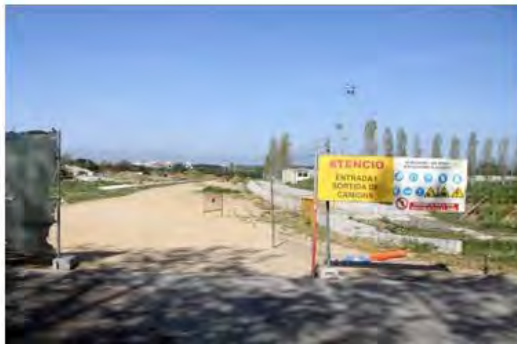
Reinici de les obres del Vial Nord de Roses
