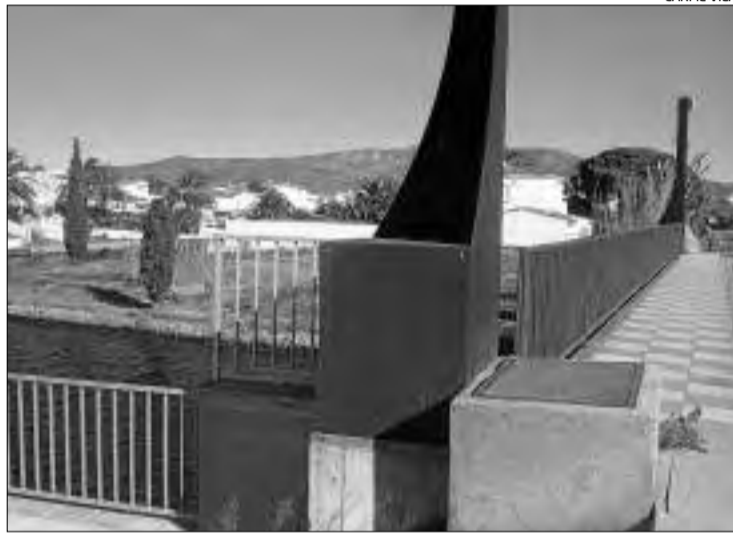
Un dels ponts en què s'està treballant.
