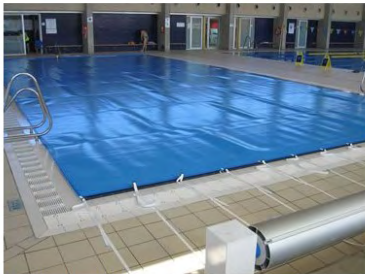
La piscina petita amb la manta tèrmica
