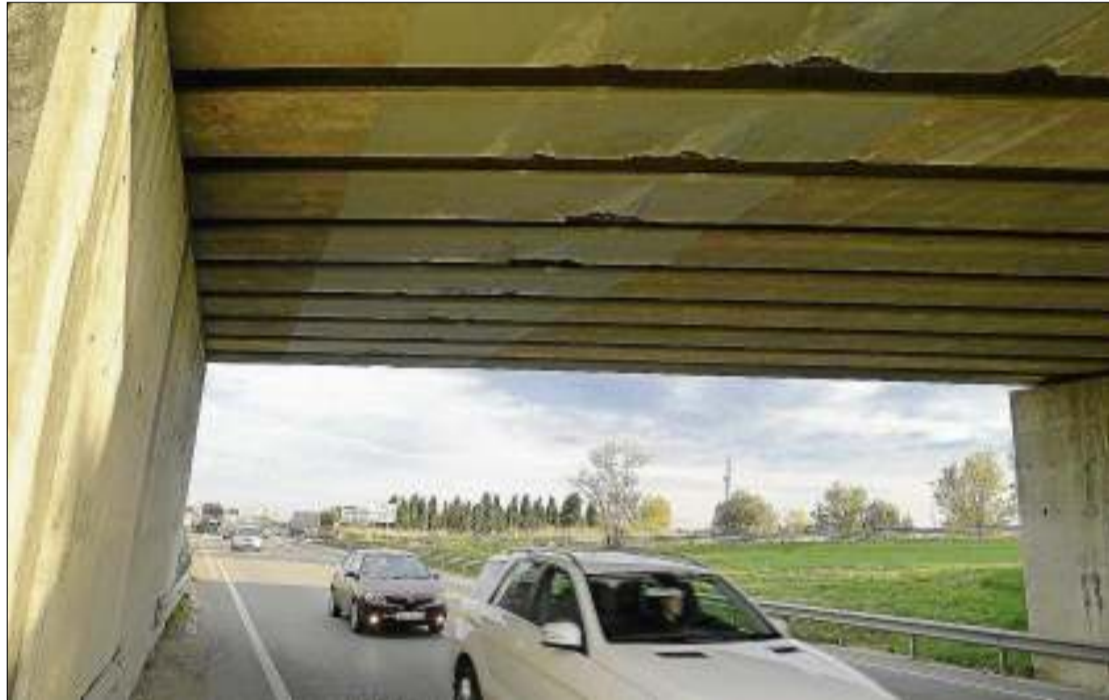
L'estat de la part inferior del pont de la N-II sobre la C-31 on un camió es va enganxar dimarts.
