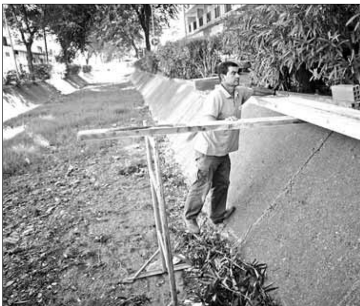
Uns operaris de Rosersa, treballant divendres passat. MONTSENY EMPORDÀ
