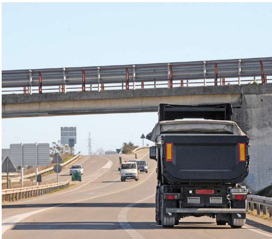
NYAP. El pont de l'N-II sobre la C-31 on diversos camions han quedat enganxats per la part superior
