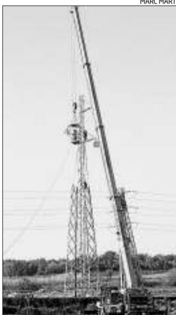
Una grua repara una torre a Salt.
