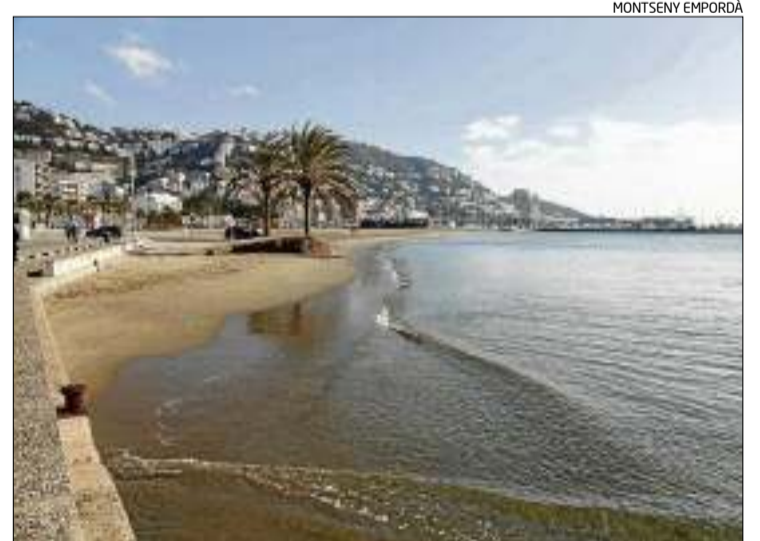
La platja de la Punta en l'estat actual, molt deteriorada.
