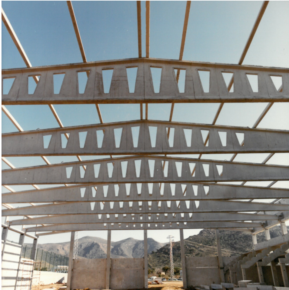
Moment de la construcció de l'estructura
