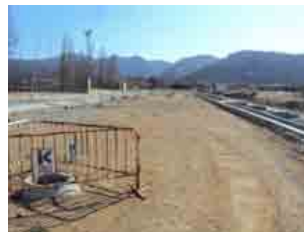
Vista general del vial
