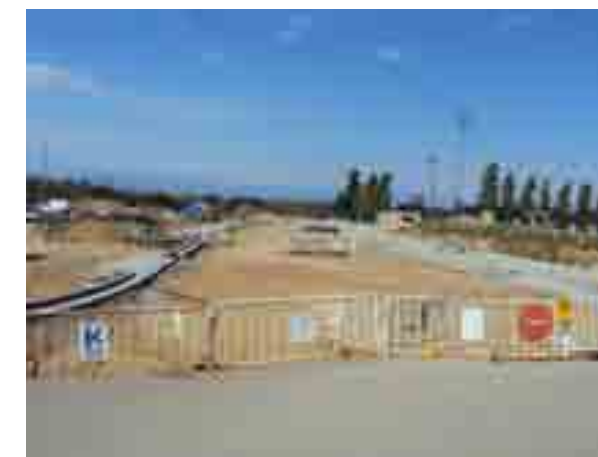
Estat general de les obres des de la rotonda
