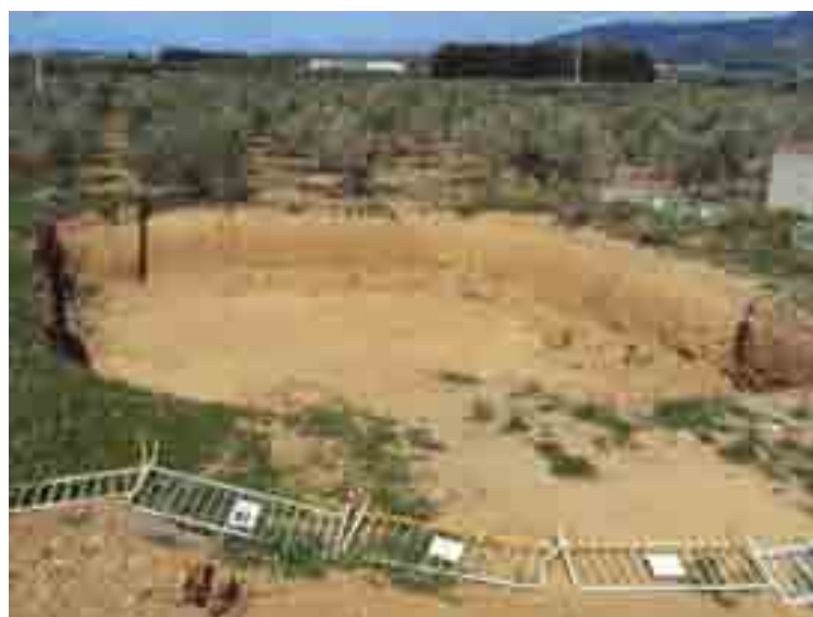
Excavació executada de la bassa de laminació d'aigües pluvials.
