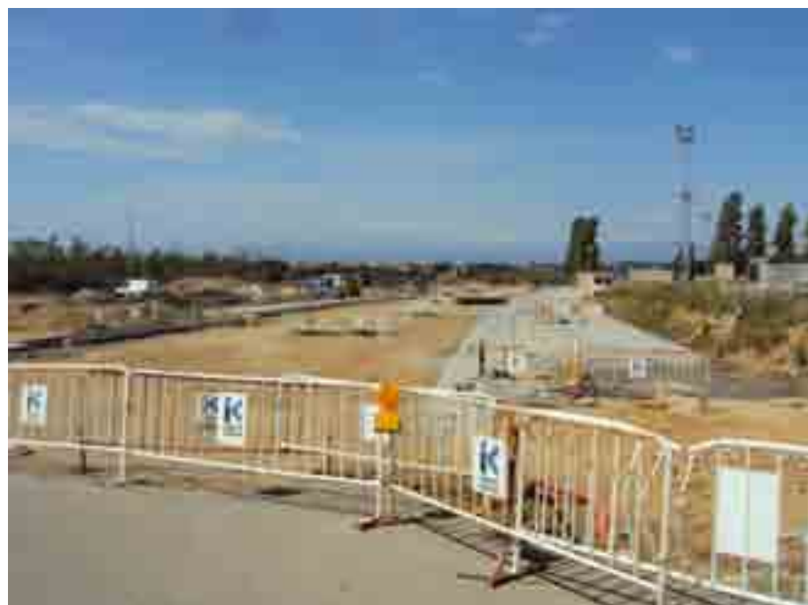
Foto núm. 7 Vorera nord
