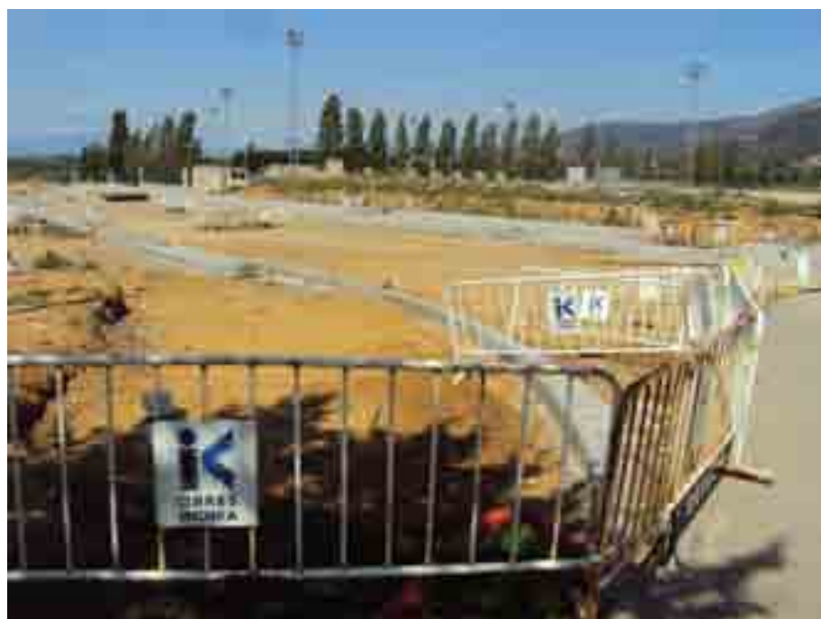
Foto núm. 27 Detall entroncament sud rotonda
