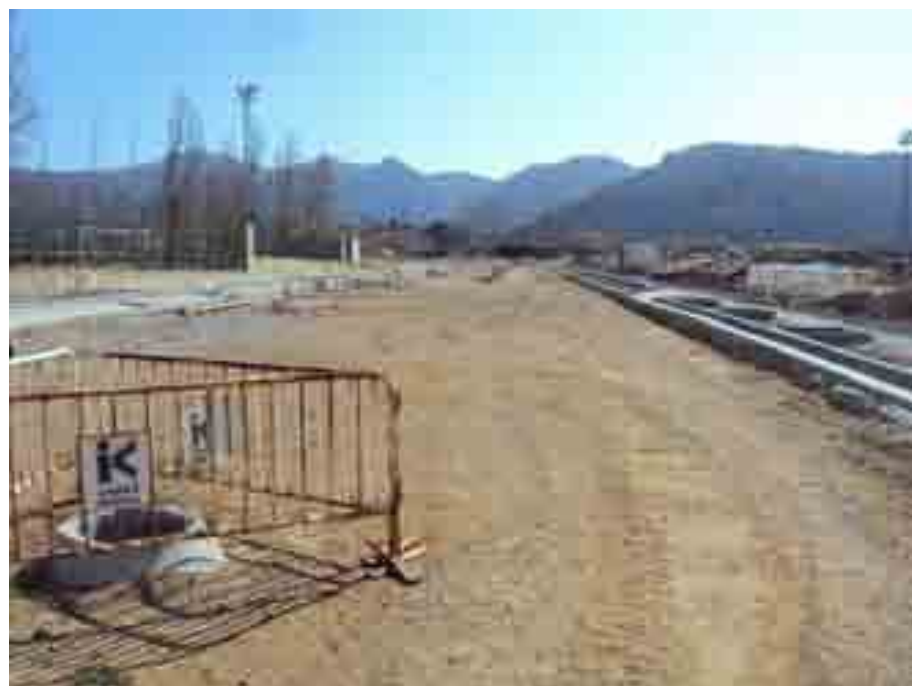
Foto núm. 1 Vista general del vial
