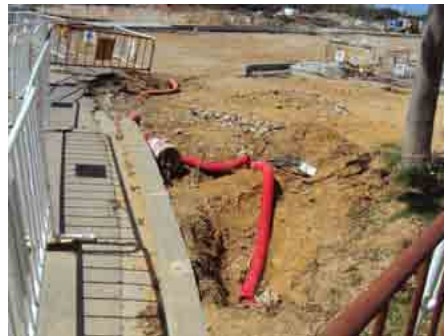
Foto núm. 26 Detall entroncament rotonda
