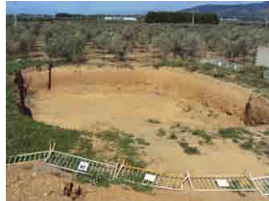
Foto núm. 18 Excavació bassa de laminació
