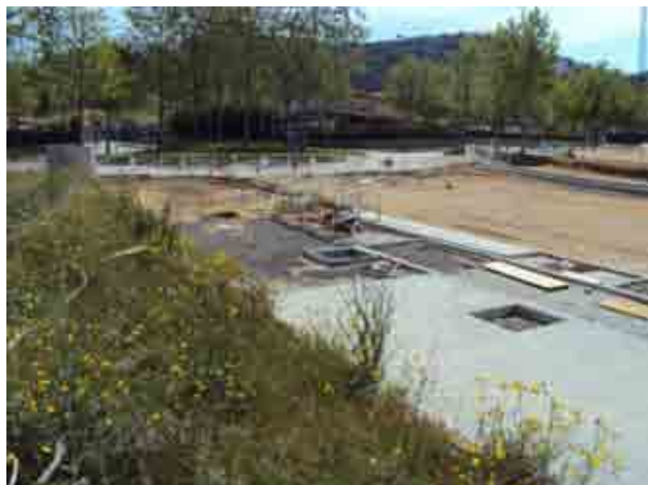
Foto núm. 11 Vista inici obra (rotonda)
