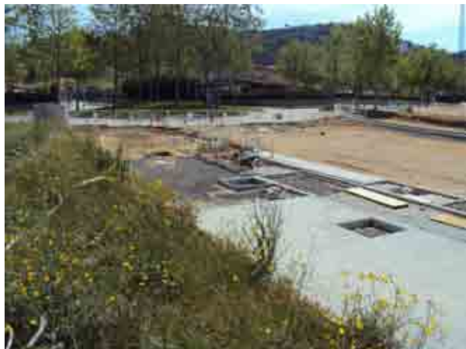
Foto núm. 25 Vista general entroncament amb la rotonda
