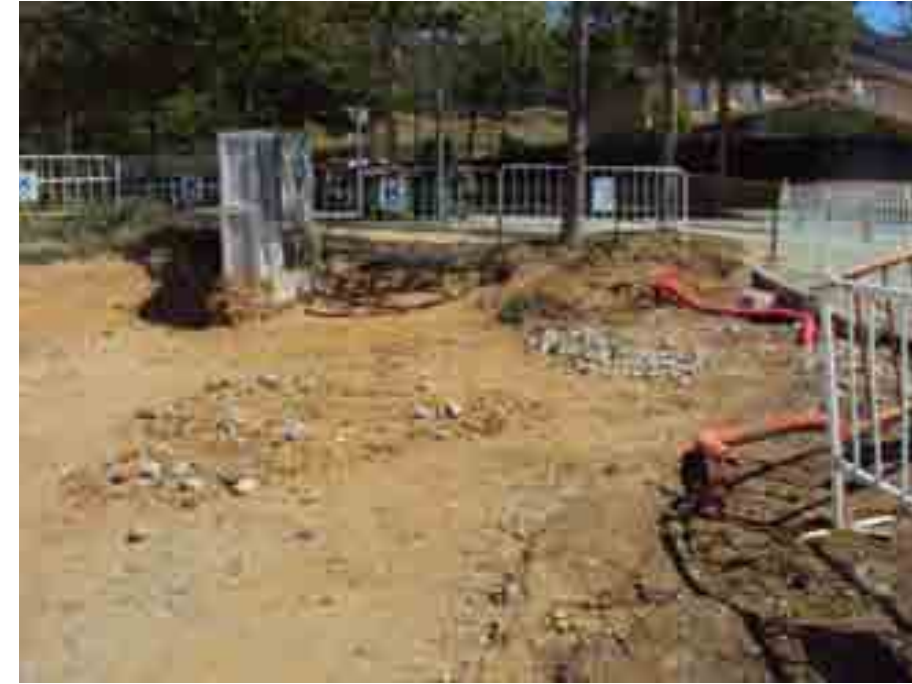
Foto núm. 14 Quadre elèctric
