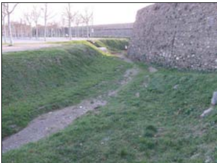
Foto 2. Traçat aigües avall amb la muralla fent de marge dret
