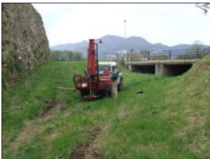
Foto3. Situació del penetròmetre P-2.
