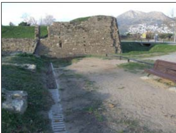
Foto 5. Desperfectes en la canal prefabricada amb reixa que drena les plujanes de l'aparcament.
