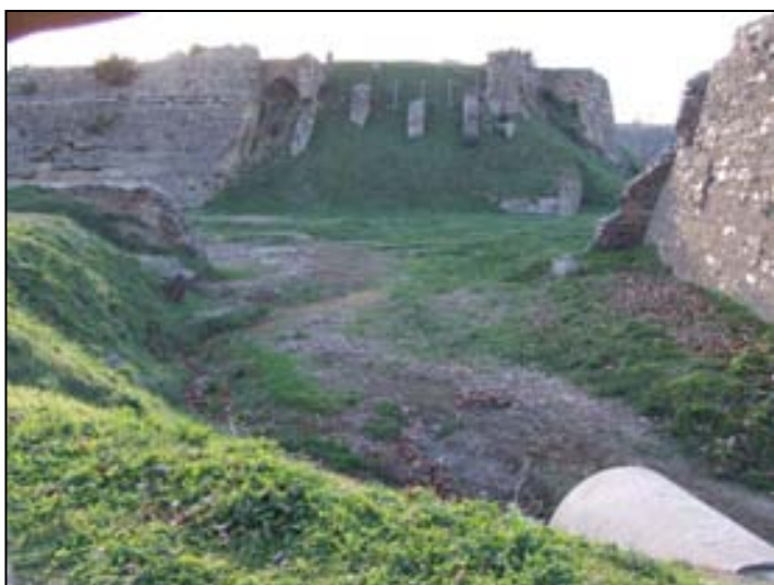
Foto 3. Tram final del rec amb la sortida al fossar.
