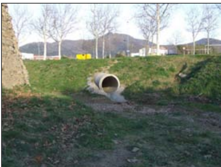
Foto 9. Tub de formigó de D100 que es connectarà als marc de formigó i que recull les plujanes.
