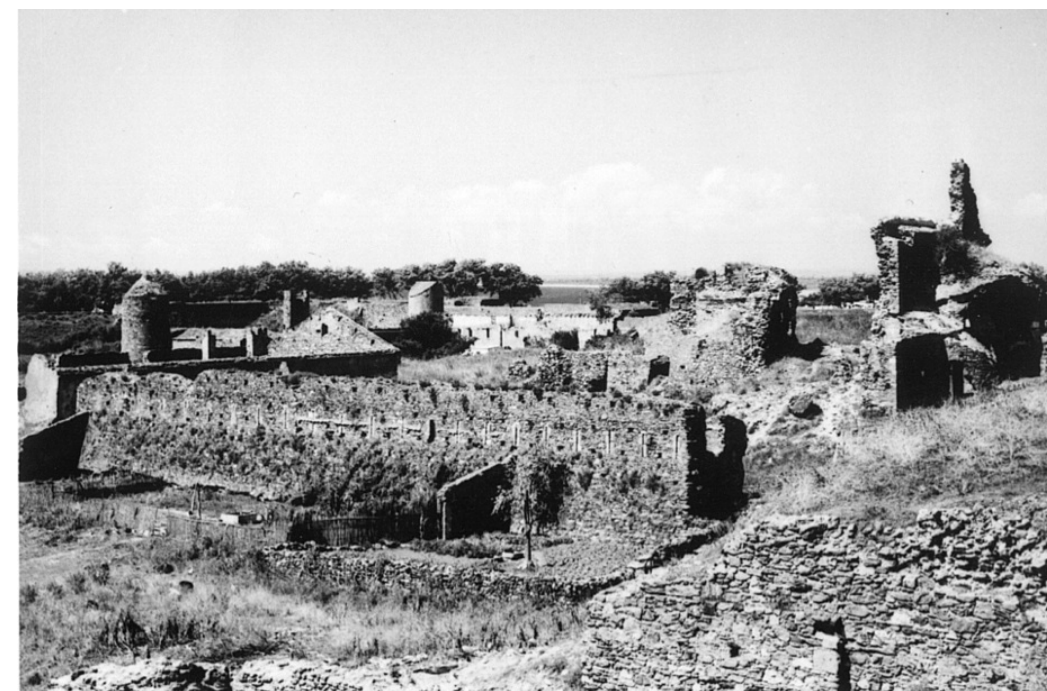
Figura 2: Vista general del sector de llevant del turó de Santa Maria a principis dels anys seixanta. Hom hi pot observar el fragment del segon recinte més ben conservat. Es tracta d'una construcció parcialment atalussada i espitllurada, la qual cosa indica l'existència d'una fortificació força potent i ben construïda.
