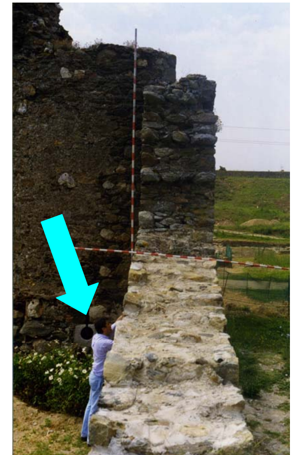
Figura 6: Espitllera per arma de foc inserida en una de les torres medievals de la façana de llevant, que denota l'adequació del conjunt a l'ús d'aquest armament.
