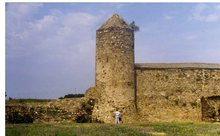
Figura 8: Torre medieval de la façana de llevant convertida en polvorí al segle XVI. Per adequar-la millor a les seves noves funcions s'eliminaren els merlets i se la coronà amb una coberta que evitava l'entrada d'aigües.
