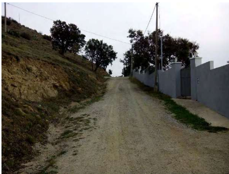
Figura 1. Estat actual carrer del Camí del Turó de l'Ullastrell
