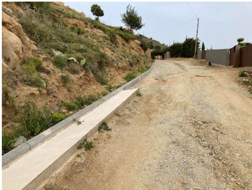
Figura 5. Tram final cuneta executada
