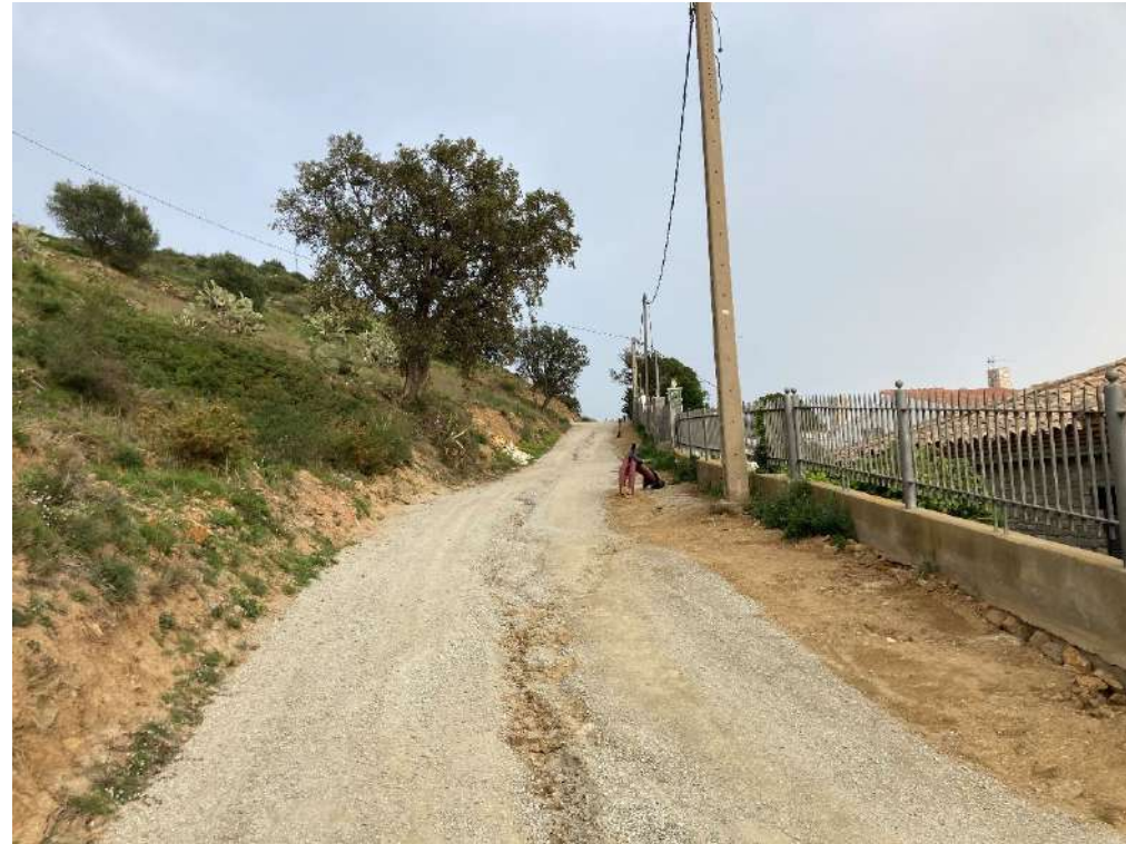
Figura 8. Estat actual tram abans creuament camí
