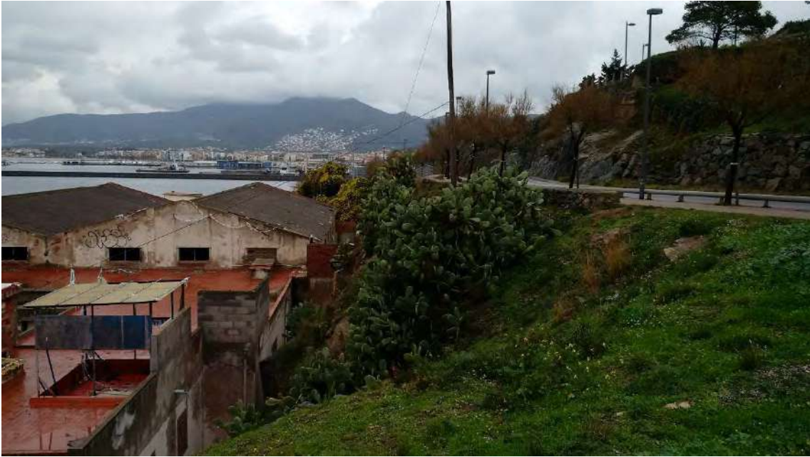
Vista del sobre de la bateria mirant cap a la depuradora de marisc.
