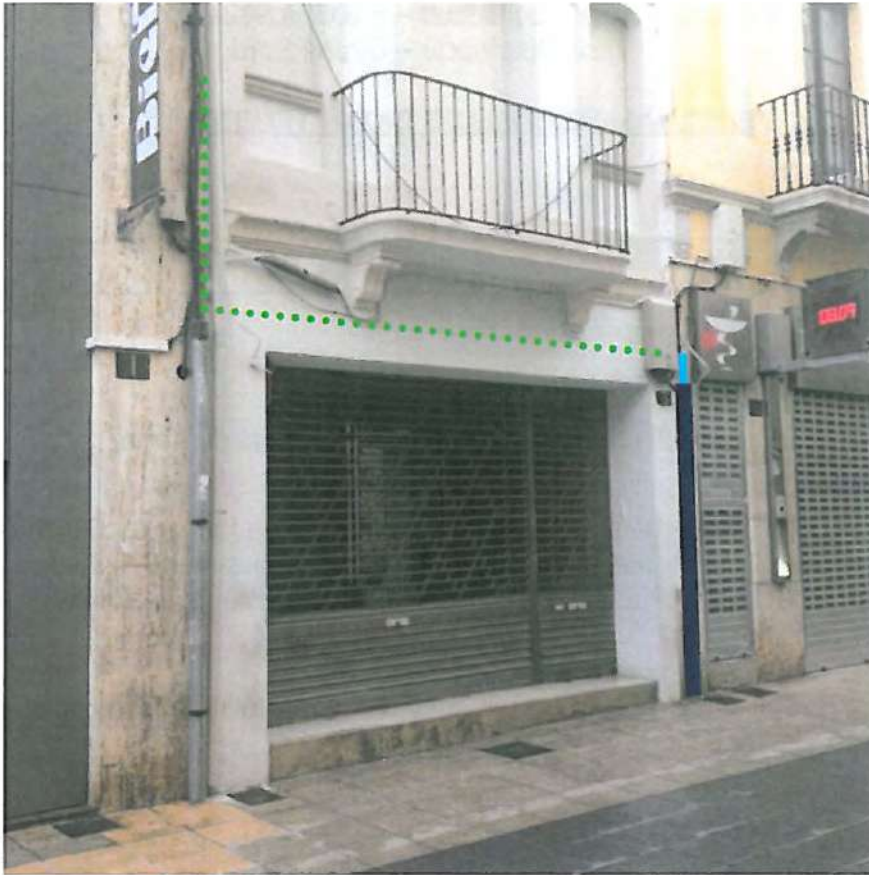
Foto - Detall substitució derivació xarxa B.T. existent .
