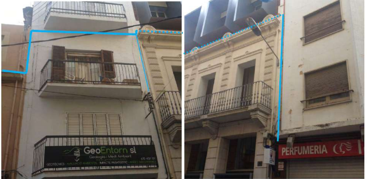
Foto - Detall traçat xarxa B.T. en façana.
