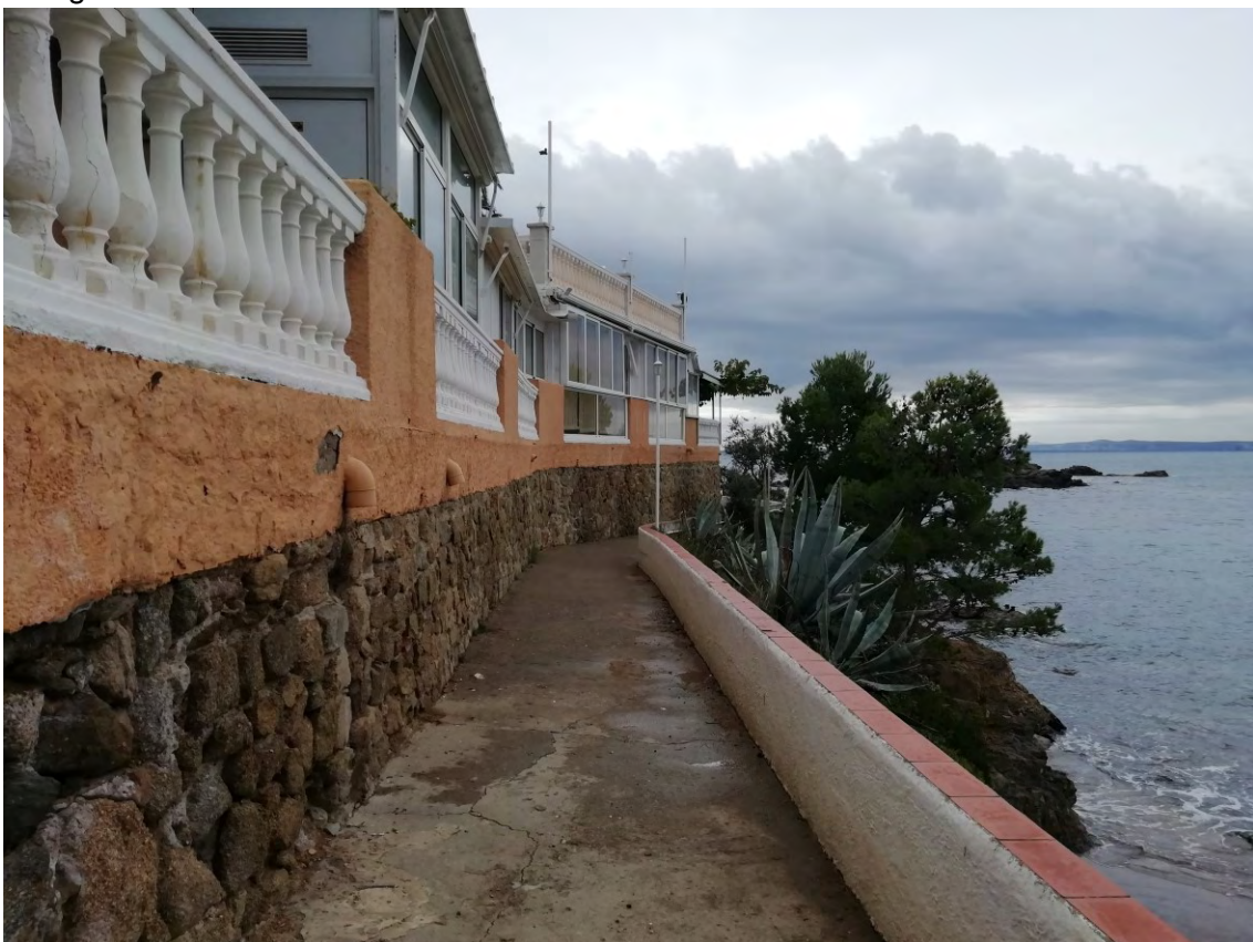
Fotografia 6. Tram camí amb paviment de formigó
