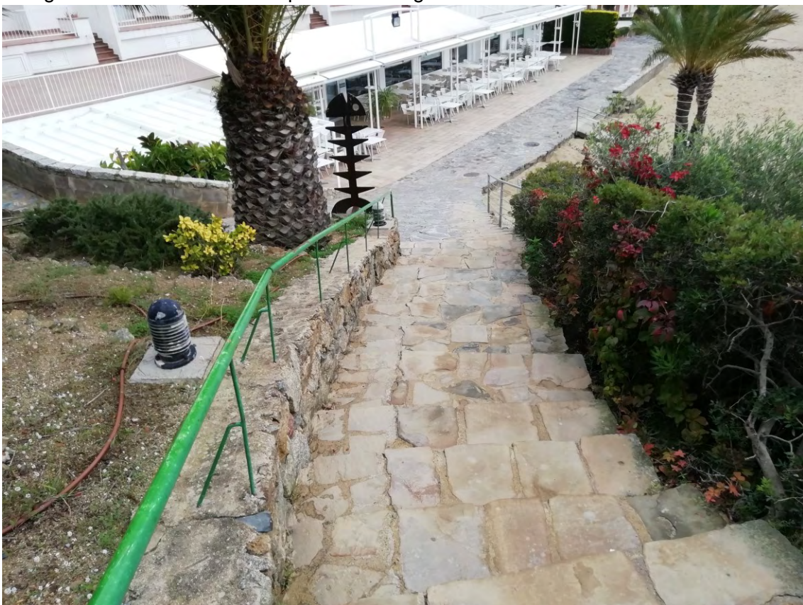
Fotografia 13. Tram camí amb presència de graonat de pedra costat Almadrava
