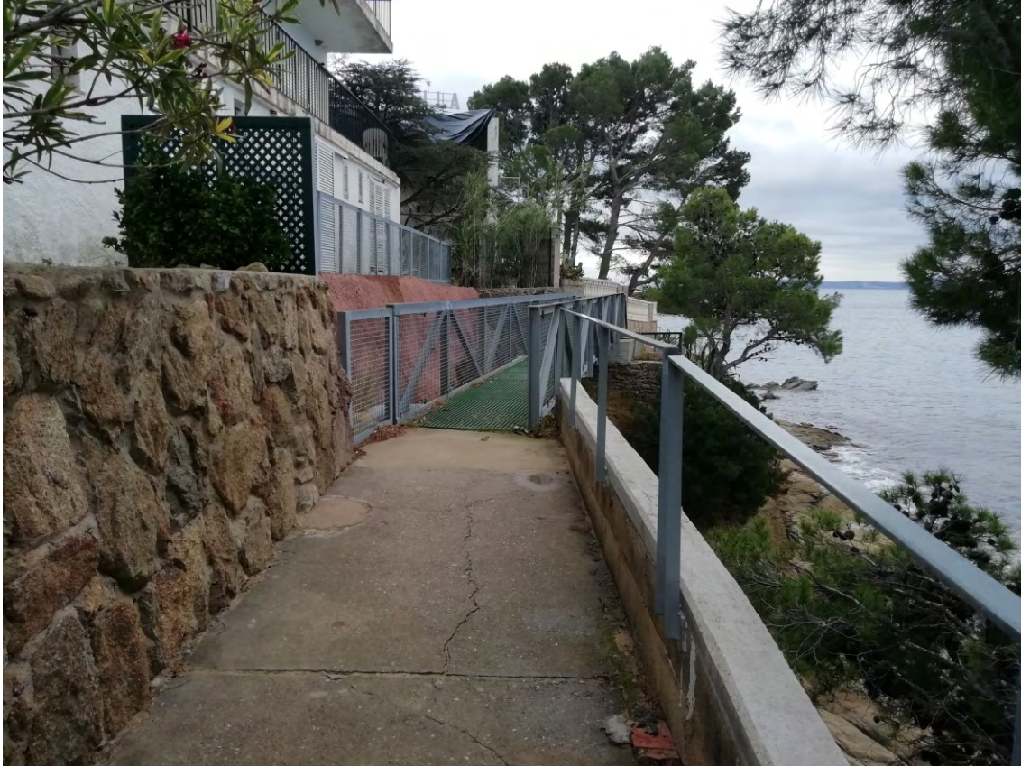
Fotografia 3. Inici Passarel.la existent d'estructura metàl.lica galvanitzada
