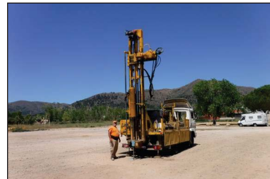
Foto 12: Ensayo DPSH P-2.
