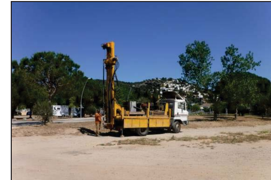
Foto 13: Ensayo DPSH P-3.
