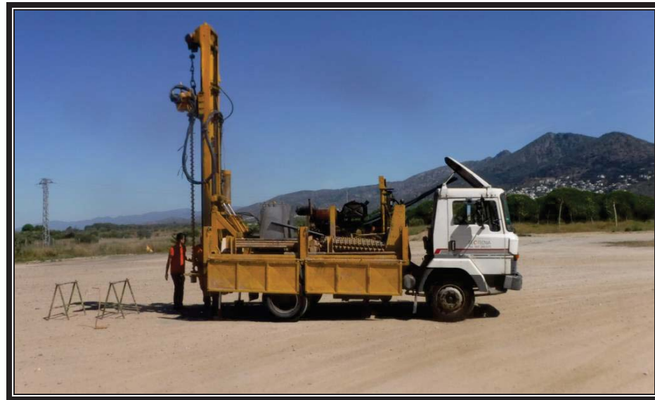
Aspecto del terreno y máquina emplazada en uno de los sondeos.
